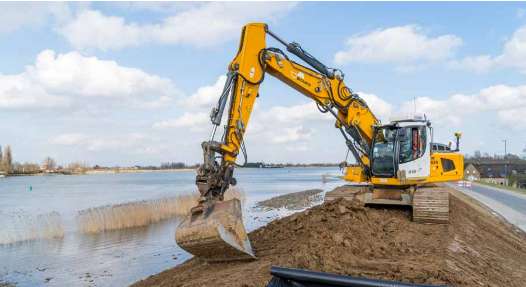
Door het verwerken van de KLIC-melding in het machinebestand (GPS-besturing) ziet de kraanmachinist in één oogopslag waar er ondergrondse kabels en leidingen liggen. Foto genomen bij het werk Kinderdijk-Schoonhovenseveer.
