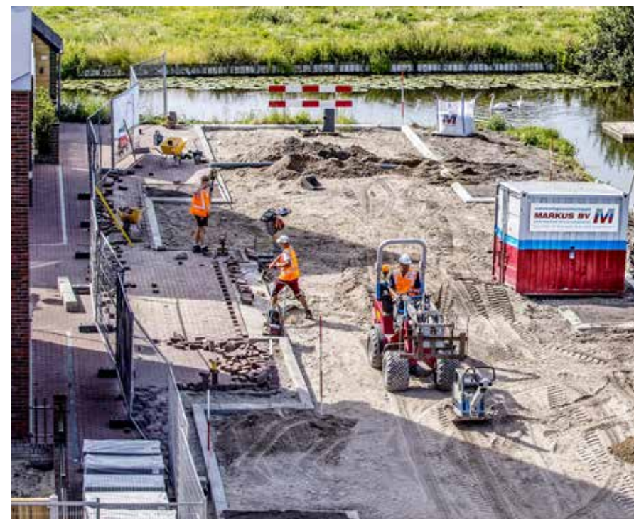
Infra werkzaamheden bij De Oevers in Roelofarendsveen.
