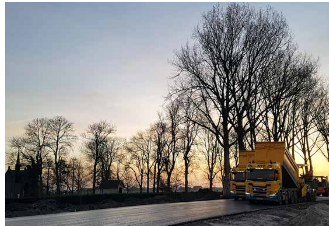
Specialisten van NTP brengen asfalt aan op de N351.
