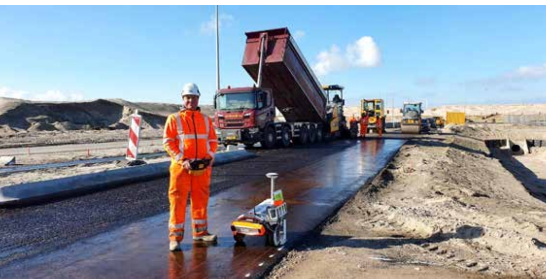
Bas den Boer print stuurlijnen met zijn robotplotter.
